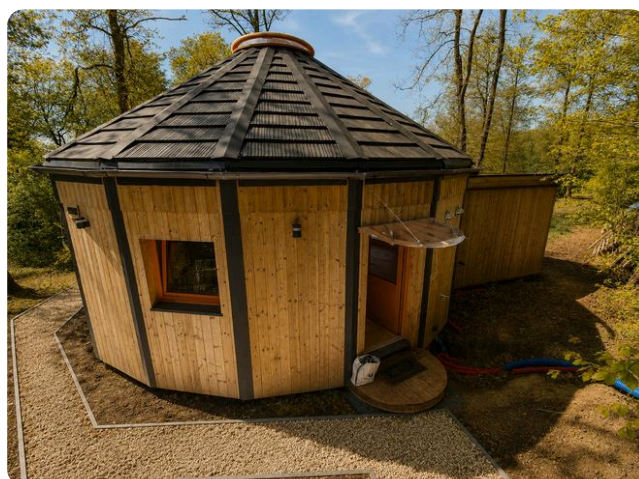
Emprise au sol et couverture en ardoise
