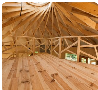
Volume sous charpente et mezzanine
