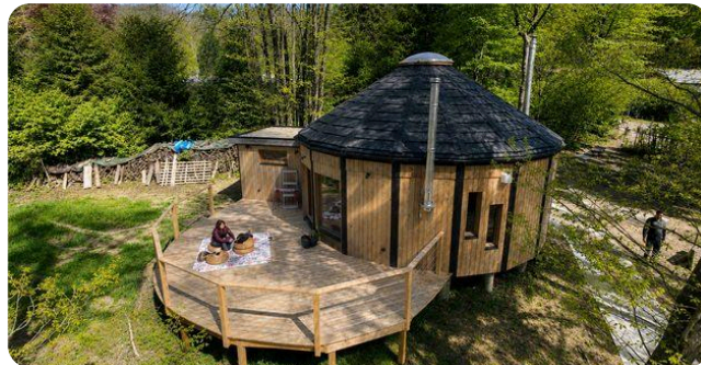
INSERTION EN LISIÈRE BOISÉE, TERRASSE ET ABORDS
