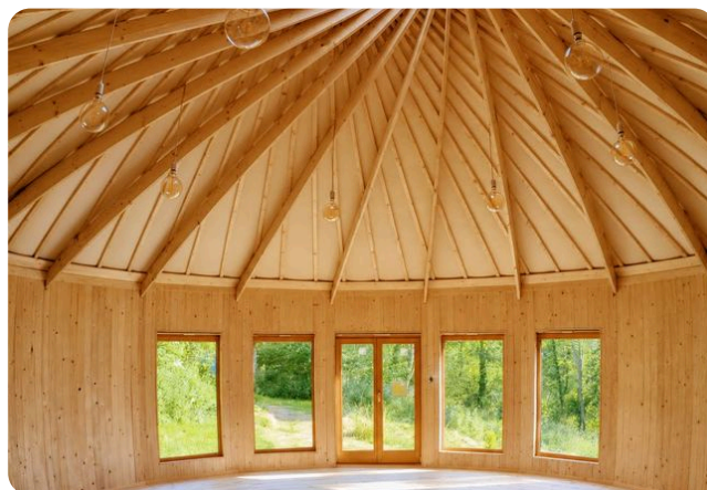
VOLUME INTÉRIEUR, CHARPENTE APPARENTE ET GRANDES BAIES
