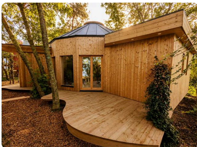
Terrasse et coupole, insertion en lisière boisée
