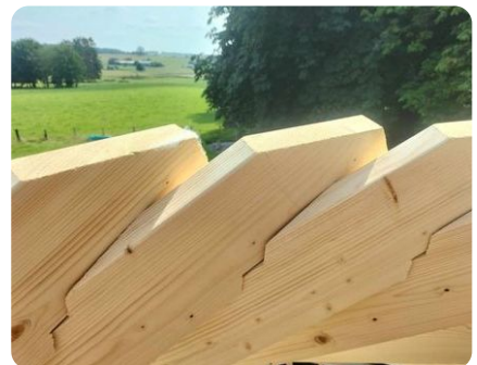
Chevrons usinés, prêts à l'assemblage
