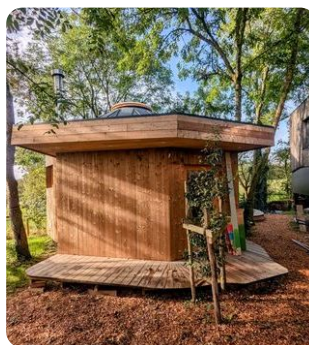
Insertion en lisière boisée, 2024
