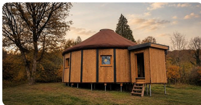
POSE SUR VIS DE FONDATION WESEASYFIX, SOL CONSERVÉ SOUS LA CONSTRUCTION
