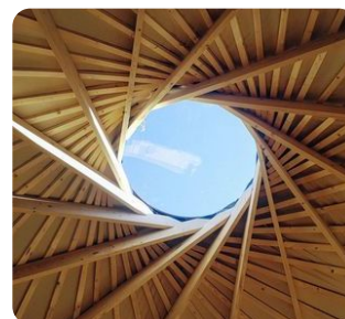
Coupole zénithale, éclairage naturel
