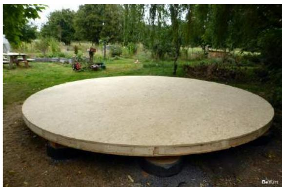
La structure du plancher isolé
